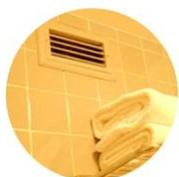
Enlevez de temps en temps la poussière des **grilles des ventilateurs** dans les toilettes et les salles de bains. Cela permet d'en assurer un fonctionnement optimal.
